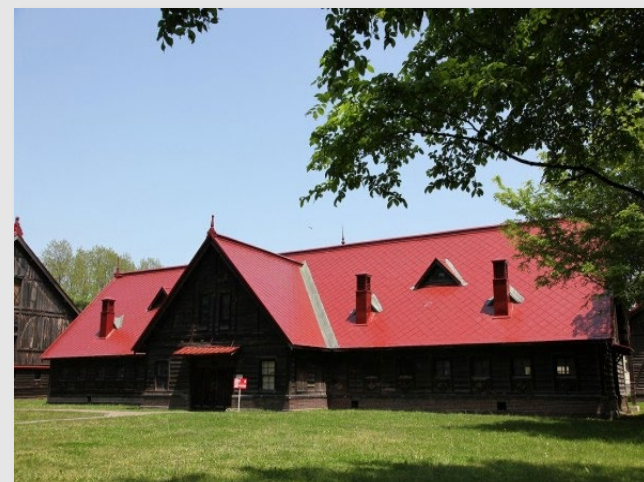
札幌農学校第二農場 牧牛舎 (木造平屋建 1909年) 重要文化財。1909（明治42年）建築。2015年（平成27年）に耐震補強工事完成。
