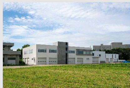
スマート農業教育研究センター (RC造2階建・S造平屋建 2023年)
