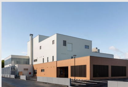
司法精神医療センター(札幌市中央区) (RC造3階建 2021年)
