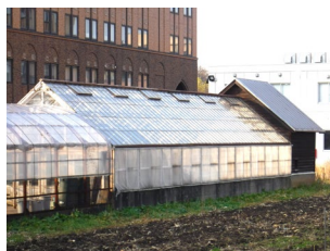
⑥-2 肥料効能実験室及金網室
