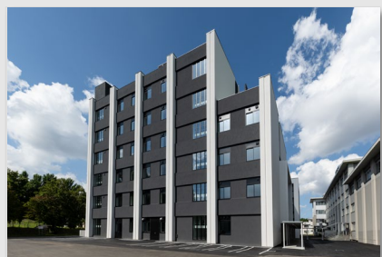
工学部資源工学研究棟 (RC造6階建 2023年)
