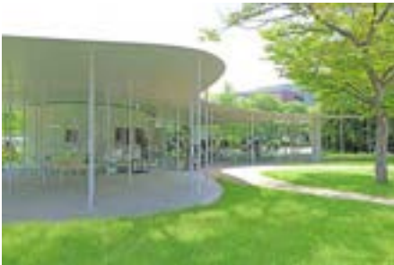
岡山大学 Junko Fukutake Terrace (Jテラス)
